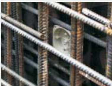
Capacul KBV fixat pe cofraj.
