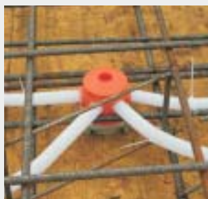
Exemplul de folosire pentru cofraj orizontal.
