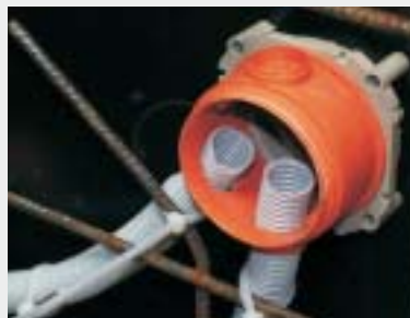
Tuburi flexibile montate în corpul KBT.
