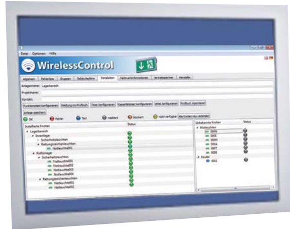
Jede im Netzwerk angemeldete Leuchte erscheint übersichtlich mit ihrem aktuellen Status in einer Liste. / Each luminaire in the network is shown clearly arranged with its actual status in a list.
